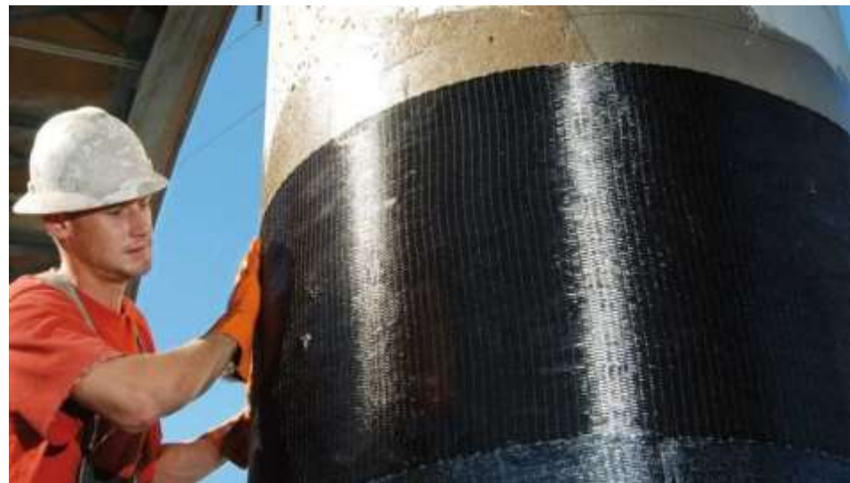
Укрепление несущих опор
