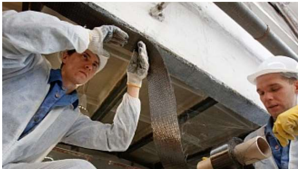
Укрепление зданий, сооружений
