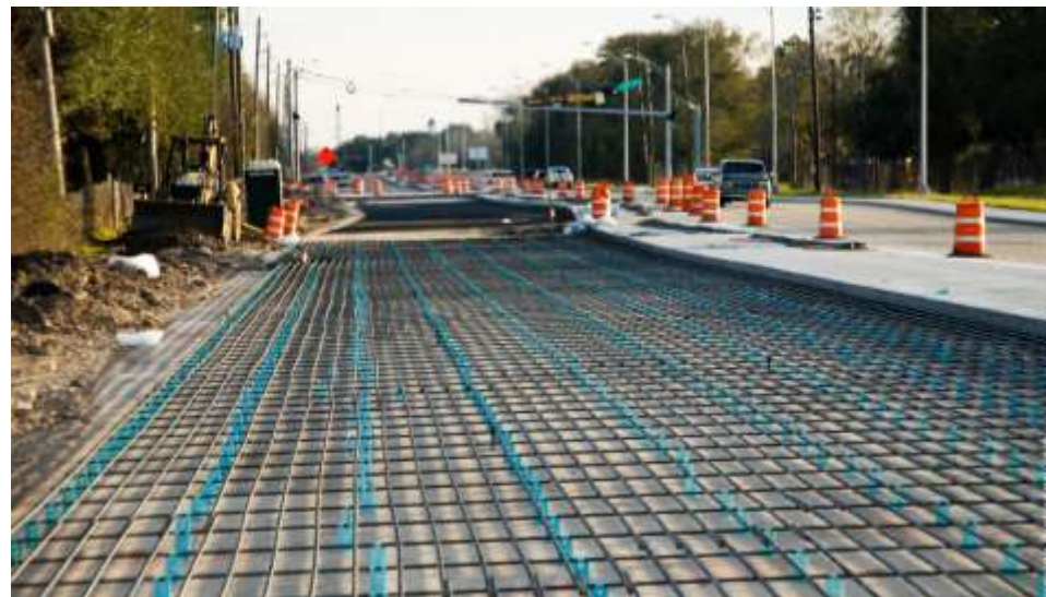
Армирование дорожного полотна композитной арматурой
