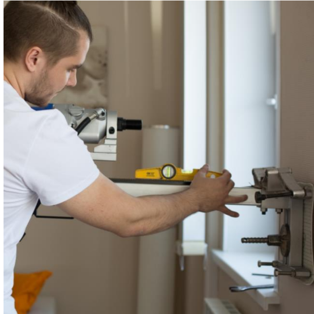
УСТАНОВКА ОБОРУДОВАНИЯ И ОСНАЩЕНИЕ ГОТОВЫХ ОБЪЕКТОВ
