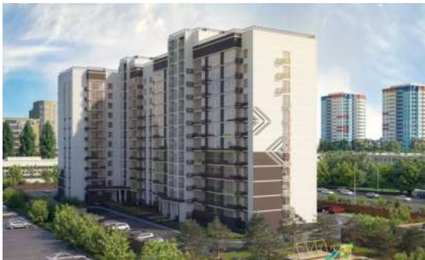
ЖК "Арт-Хаус" г. Волгоград Щиты и НВА, монтажные изделия, кабеленесущие системы
