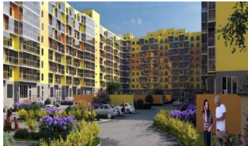
ЖК «Добрыня», г. Санкт-Петербург Низковольтная аппаратура
