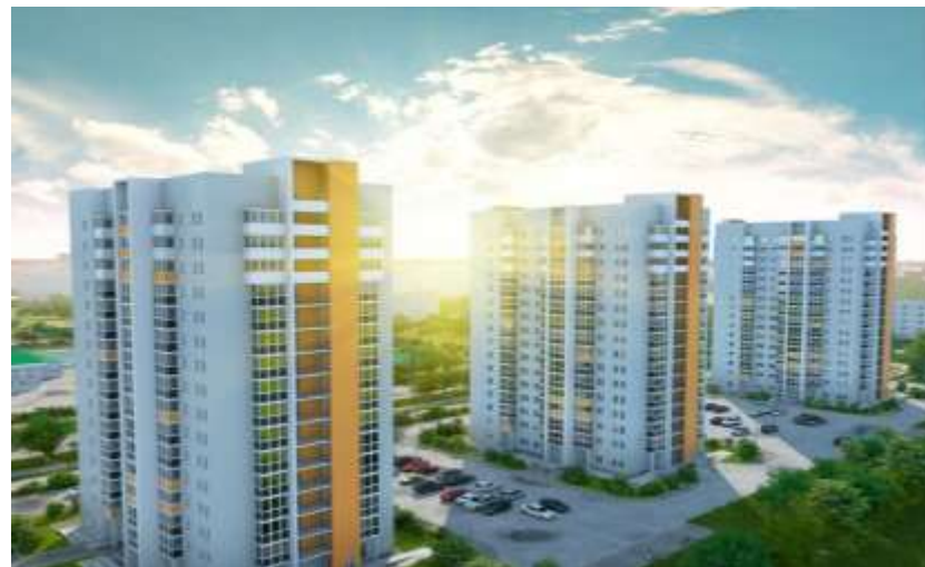
ЖК «Ахтуба Сити», г. Волжский Щиты и НВА, монтажные изделия, кабеленесущие системы
