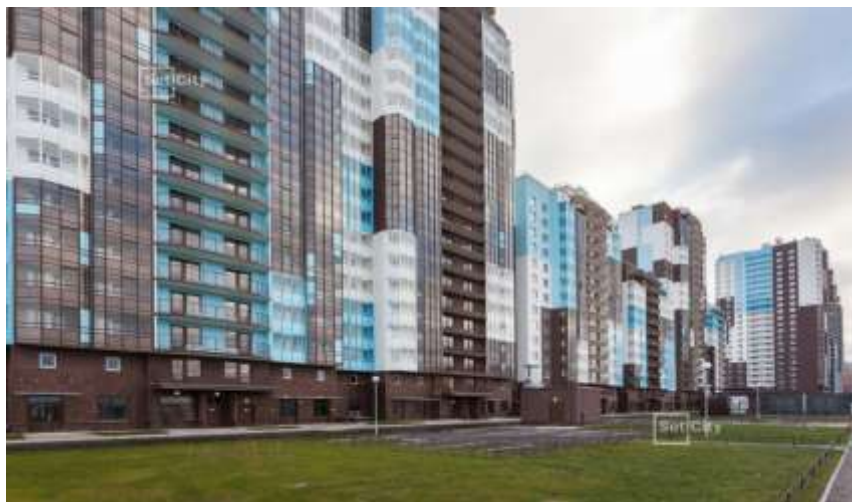
ЖК «Чистое Небо», г. Санкт-Петербург Низковольтная аппаратура
