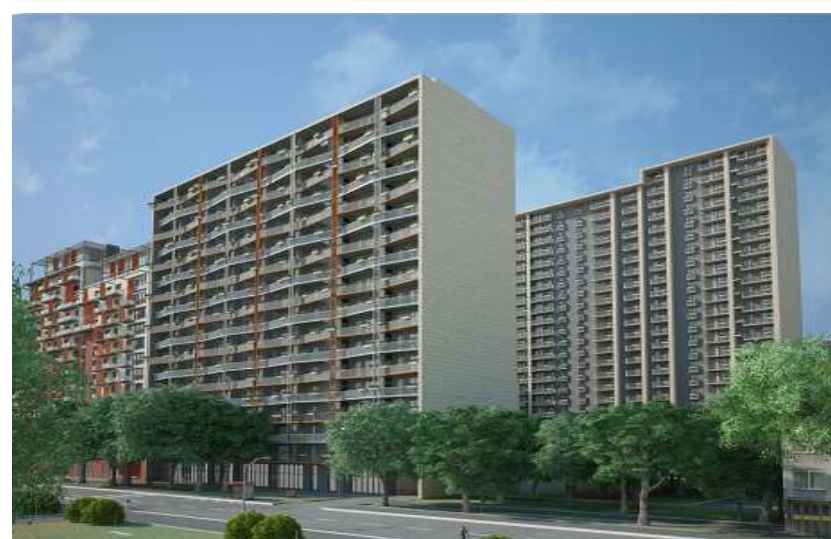
DOMUS. Сакартвело (Грузия). Тбилиси. Щиты, модульное оборудование, монтажные изделия
