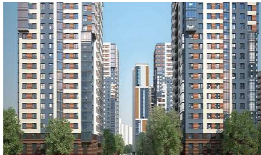
ЖК «Калейдоскоп», г. Санкт-Петербург Низковольтная аппаратура
