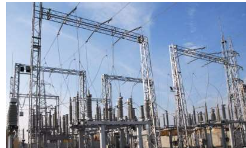
Реконструкция Армянской Электросети. г.Ереван Низковольтное и щитовое оборудование.
