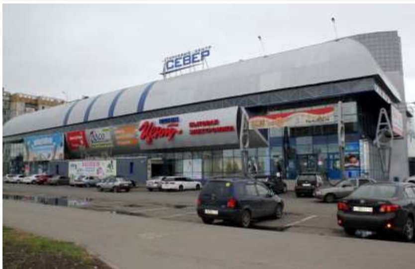
ТЦ «СЕВЕР», г. Кемерово Щиты, Боксы, КНС, Монт. изделия.
