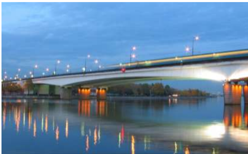
Нагатинский Метроост в Москве. Низковольтное и щитовое оборудование
