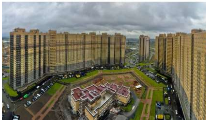
ЖК «Северная Долина», г. Санкт-Петербург Низковольтная аппаратура и электроустановка
