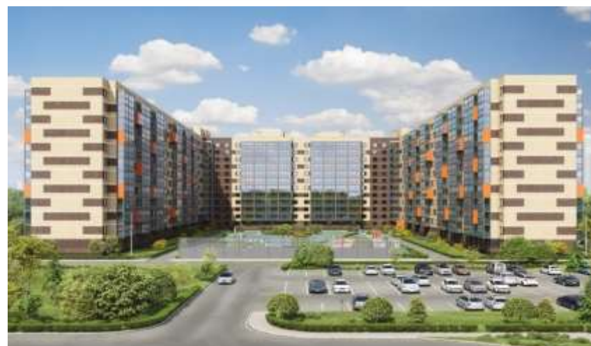
ЖК «Муринский Пассат», г. Санкт-Петербург Низковольтная аппаратура
