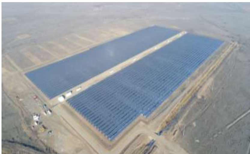
Ахтубинская солнечная станция (Астраханская обл.)
