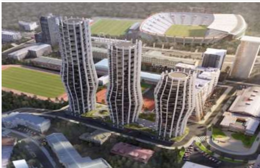
Alliance Group. Сакартвело (Грузия). Электроустановка и освещение
