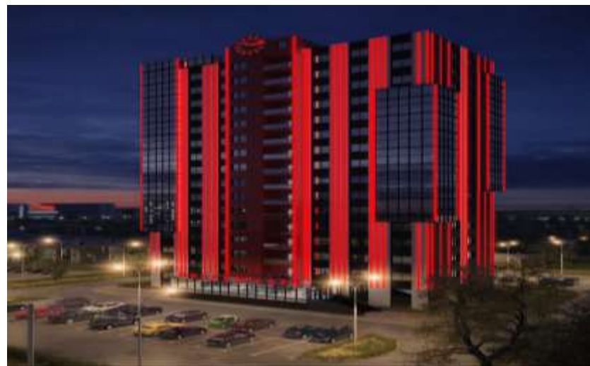
Офисный центр "Москва Плаза" Щитовое оборудование
