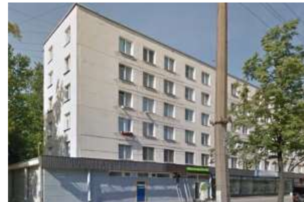
Latvija, Rīga, Elvīras iela, 15, 1939 г.п. Кладка без отделки, D700, Siporex
