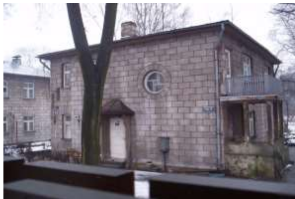
Latvija, Rīga, Elvīras iela, 15, 1939 г.п. Кладка без отделки, D700, Siporex
